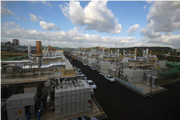
1 그림 4 | 경기 화성 그린에너지 파크의 MCFC 발전소
