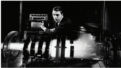
| 그림 3 | 1961년 오하이오 주 클리블랜드(Cleveland)의 루이스(Lewis) 연구센터에서 만든 초기 플라즈마 추진 엔진-NASA
