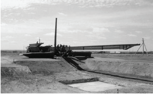
횡단할 간격 위로 거더(Girder) 전개
